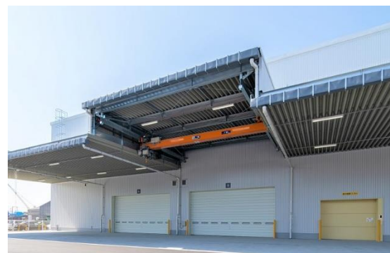
【東側トラックバース 天井クレーン (低床)】
