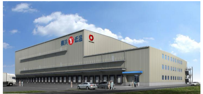
《B棟》冷凍・冷蔵倉庫
