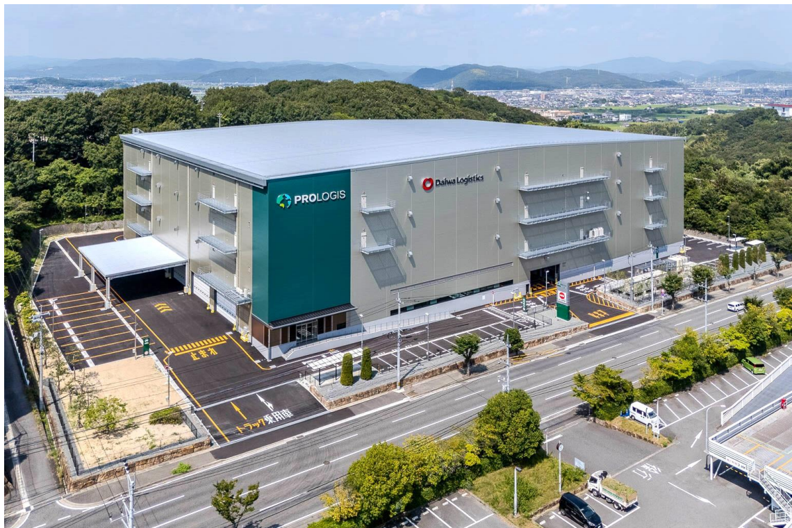
【新潟物流センター 外観】
