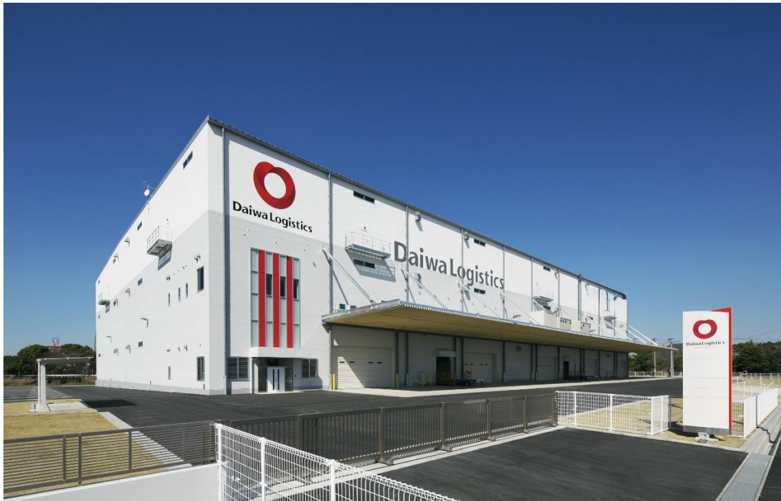
【名古屋南物流センター 外観】
